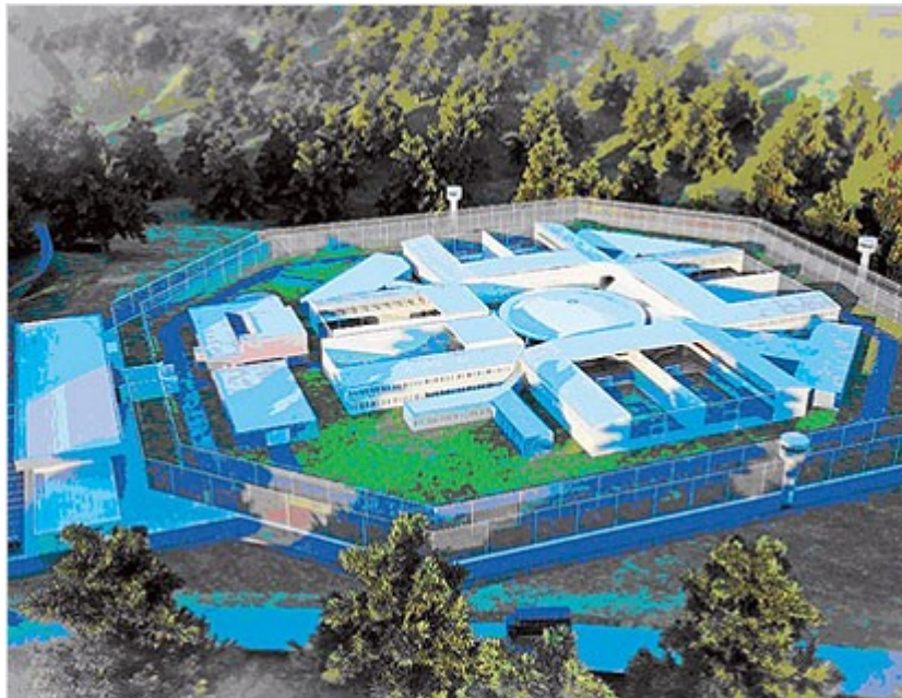
Figura 9: Complexo Penitenciário em Minas Gerais
